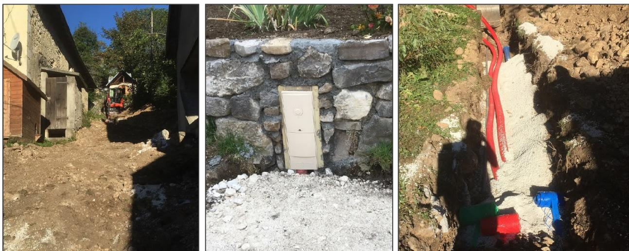
Dès le printemps 2017 les travaux reprendront : raccordement des habitations (électricité, téléphone), enlèvement des poteaux, terrassement et goudronnage de la plateforme.
